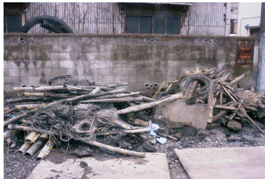
地中混入物撤去状況 2
