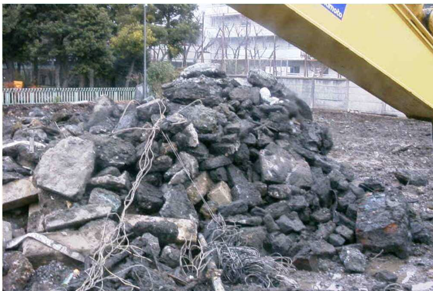
地中混入物撤去状況 1
