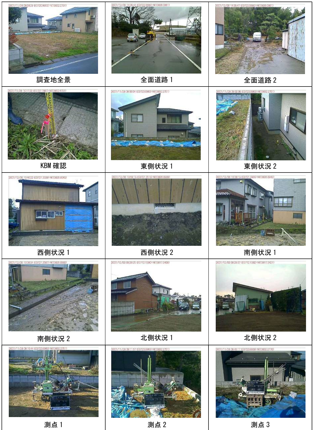
図 1-3-42 現場写真撮影例 1
