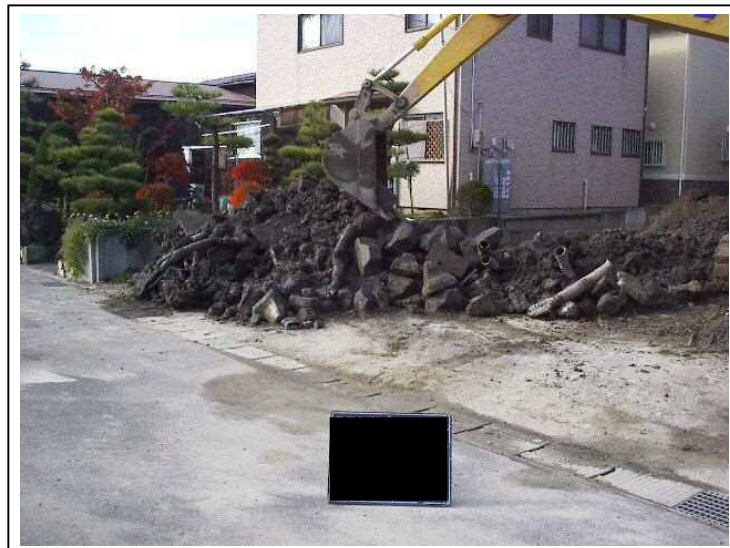
図 1-2-8 地中内障害物の撤去状況
