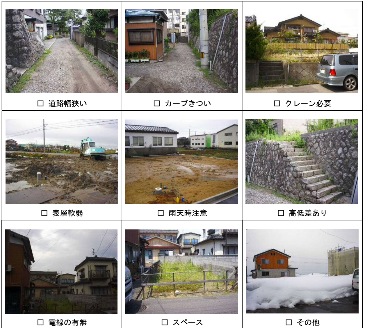
図 1-2-38 施工支援写真例
